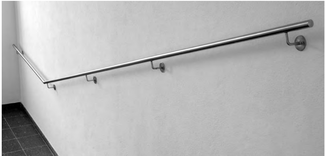
Handlauf im Treppenhaus einer Schule
