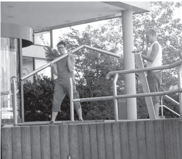
Montage des fertigen Geländers
