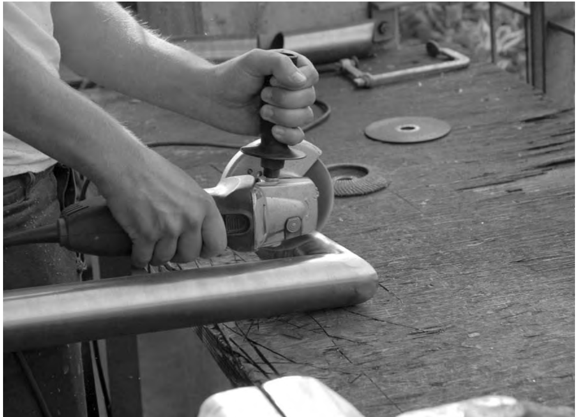
Metallarbeiten an Geländerteilen
