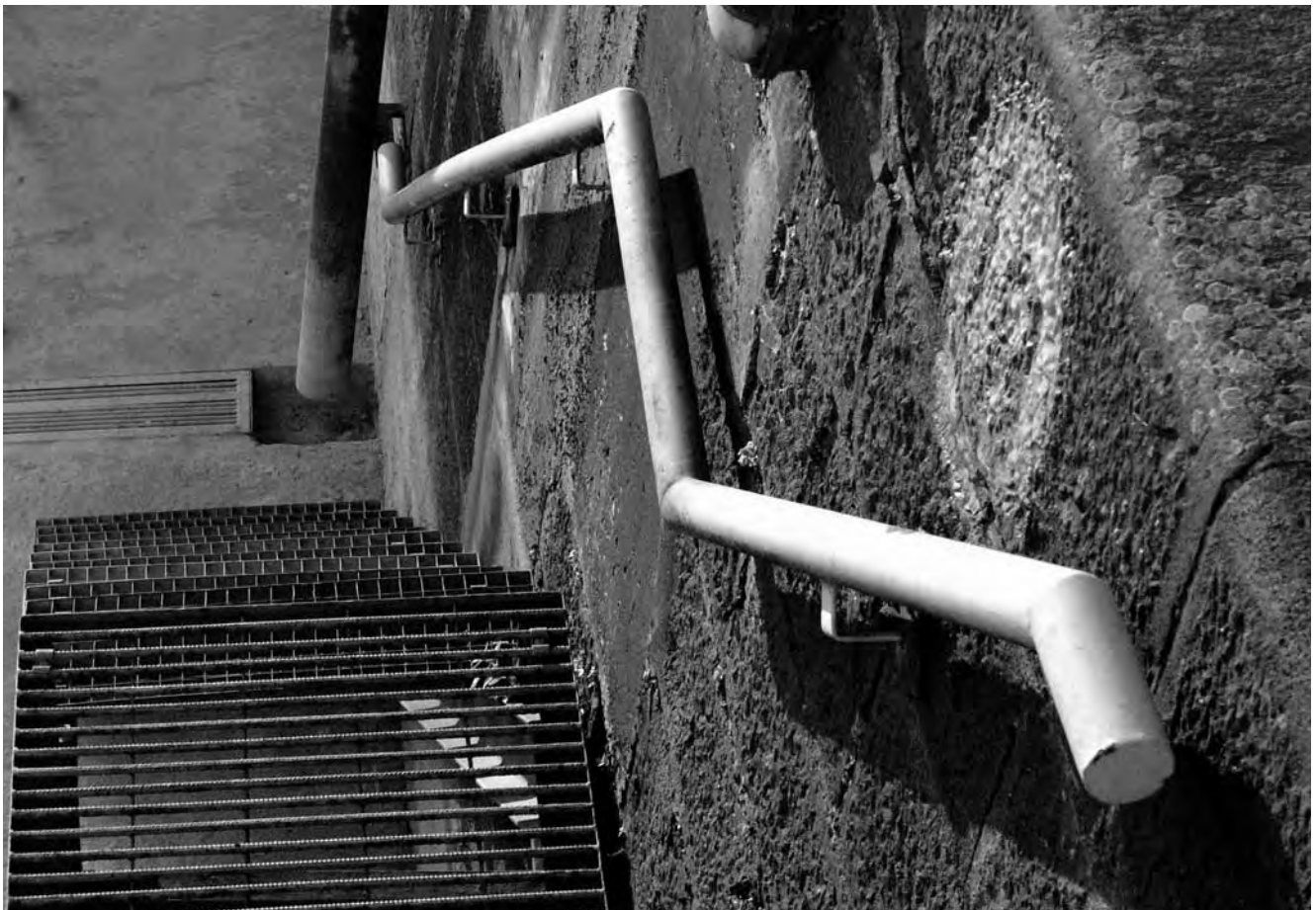
Handlauf an der Hafenmauer
